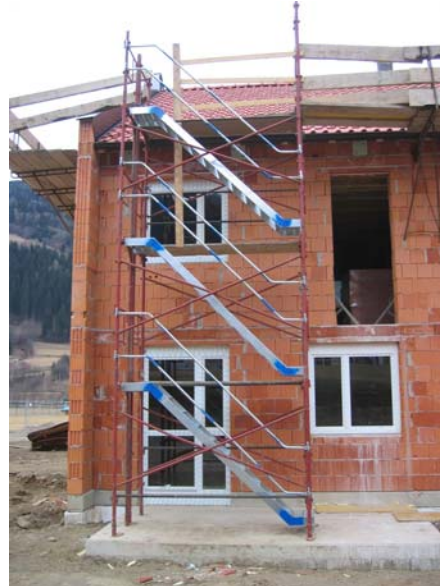
Treppenturm als optimaler Verkehrsweg
